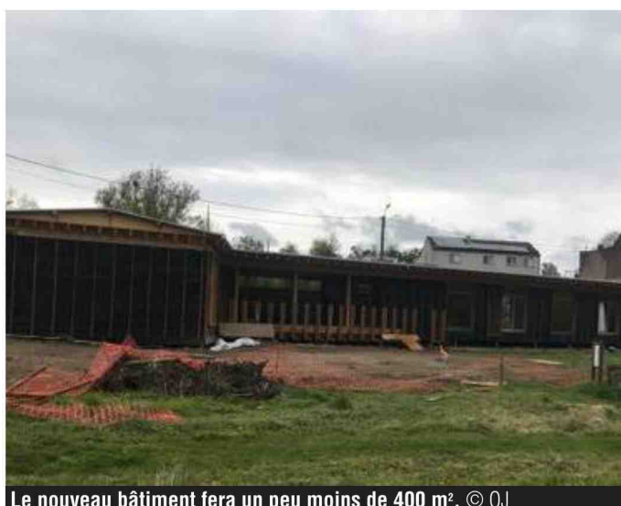
Le nouveau bâtiment fera un peu moins de 400 m 2 . © OJ
